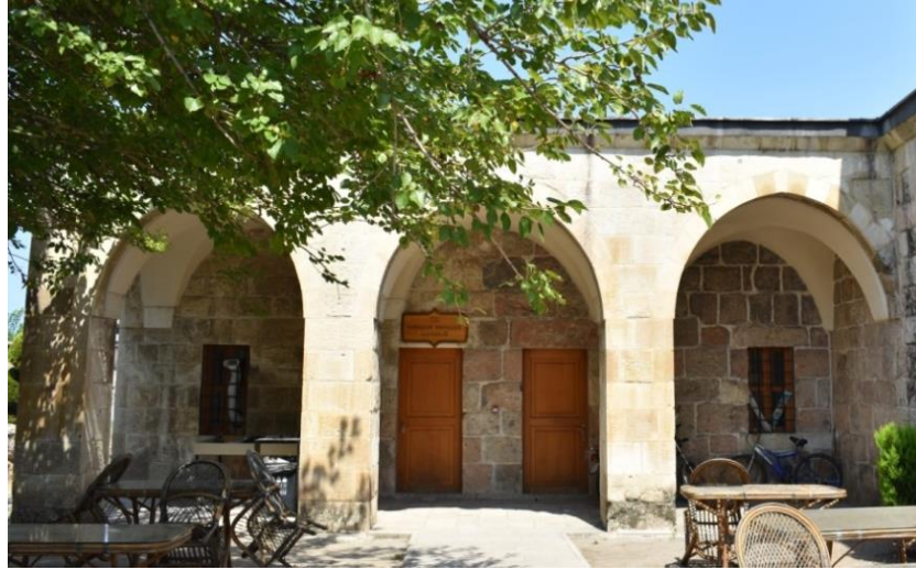
Fotoğraf 7: Hatay Payas Sokullu Mehmed Paşa Külliyesi Sıbyan Mektebi, giriş revakı.
