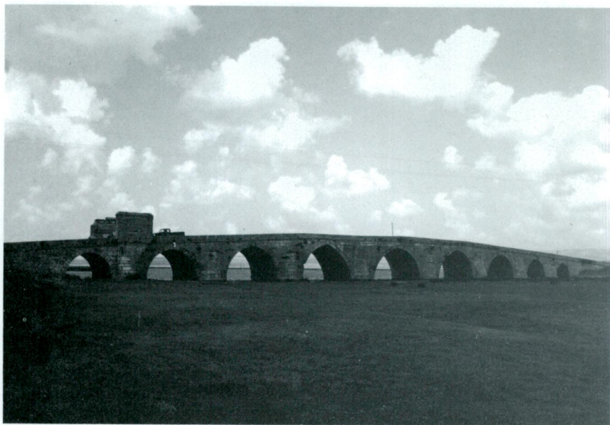
Fig. 10a — Büyük Çekmece bridge.
