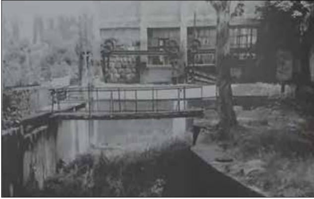
Fotoğraf 5: Çukurova Sanayi İşletmeleri hidroelektrik santrali genel görünüm (Uğur Pişmanlık Arşivi) / General view of Çukurova Industrial Enterprises hydroelectric power plant
