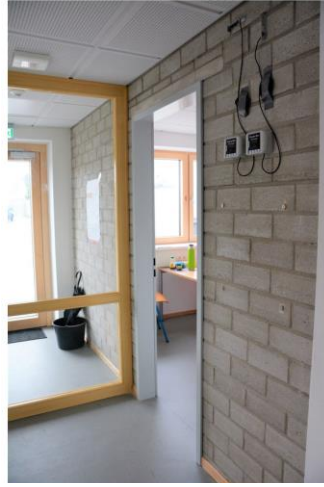
Şekil 5. Geri dönüştürülmüş malzemelerin uygulandığı duvar (Hlawatsch vd., 2018)
