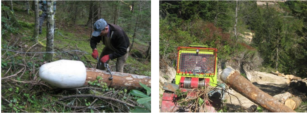
Şekil 13. Fiber ve sac başlıkla başlıkla ürünlerin orman yoluna kablo çekimi Figure 13. Logs pull up to the forest road with cabling with fiber and steel helmets
