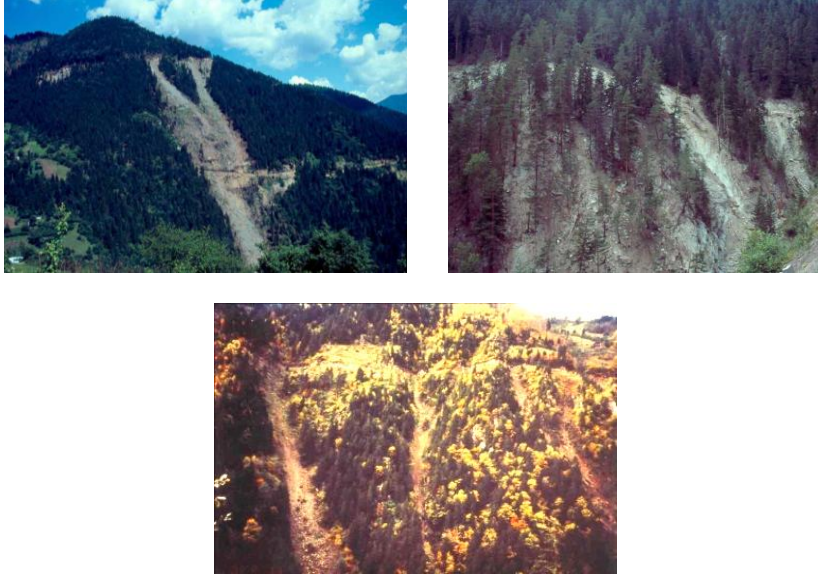
Şekil 1. Orman yol inşaatı sonrası ortaya çıkan bazı çevresel problemler Figure 1. Some environmental problems have occurred after forest road construction
