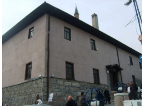
14. Şekil: Ahi Elvan Cami Çift Katlı Pencere
