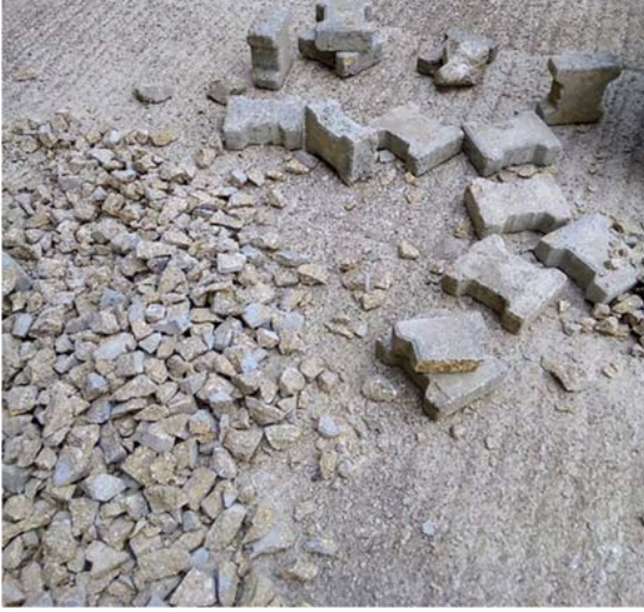
Şekil 1. Atık parke taşı (Waste interlocking concrete paver)
