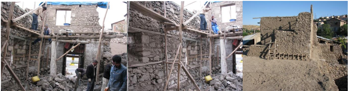
Şek. 65-67: Sağır Müftü Konağı Onarım Görünüşleri (Ş. Öztürk 2009)
