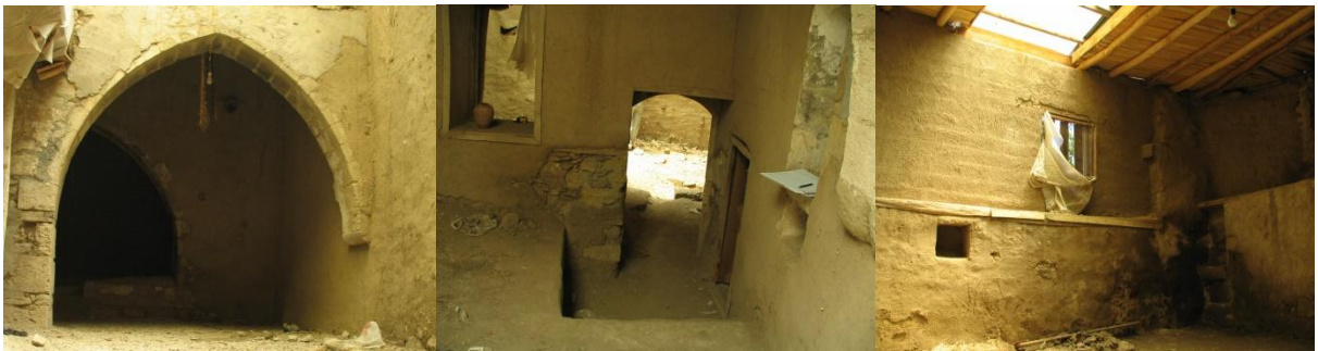
Şek. 15-17: Sağır Müftü Konağı Servis Bölümü Görünüşleri (Ş. Öztürk 2008)
