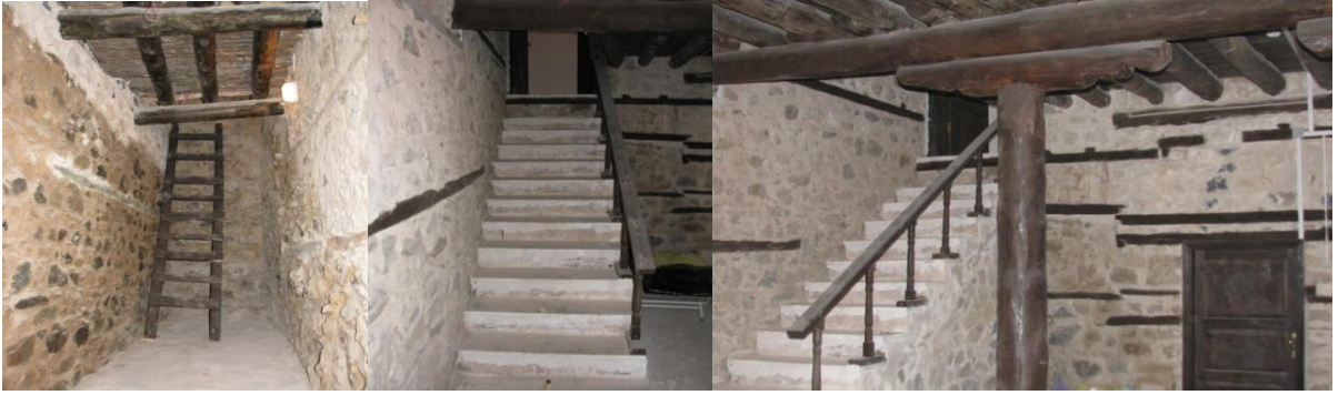
Şek. 89-91: Sağır Müftü Konağı Onarım Sonrası İç Mekân Merdiven Görünüşleri (Ş. Öztürk 2009)
