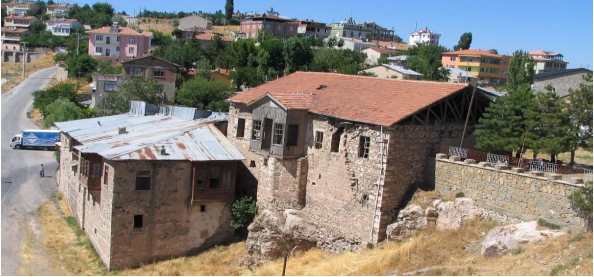
Şek. 14: Sağır Müftü Konağı Güneybatı Genel Görünüşü (Ş. Öztürk 2008)
