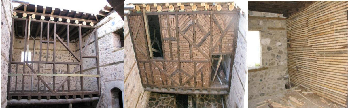
Şek. 71-73: Sağır Müftü Konağı Onarım Görünüşleri (Ş. Öztürk 2009)
