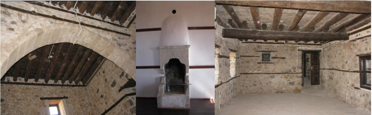
Şek. 92-94: Sağır Müftü Konağı Onarım Sonrası İç Mekân Görünüşleri (Ş. Öztürk 2009)
