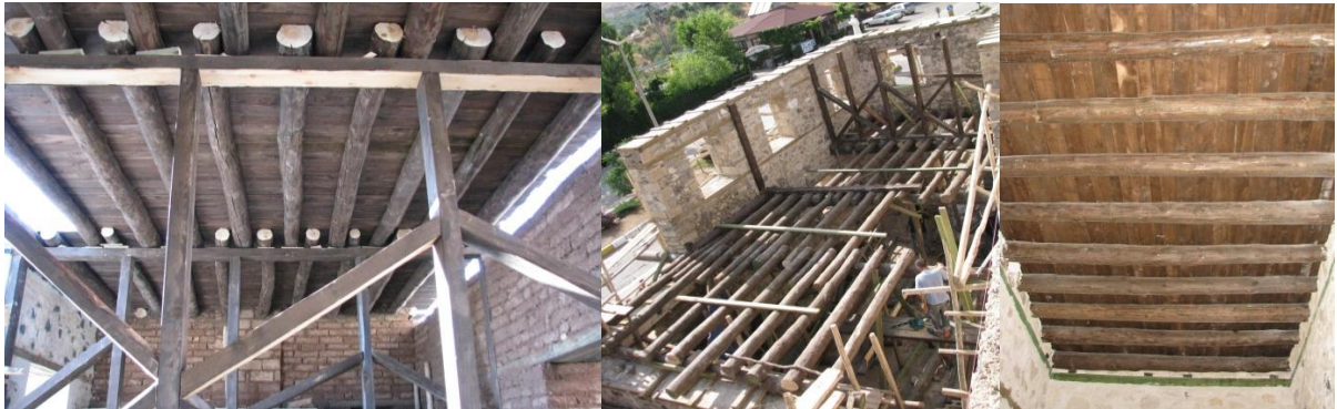
Şek. 74-76: Sağır Müftü Konağı Onarım Görünüşleri (Ş. Öztürk 2009)
