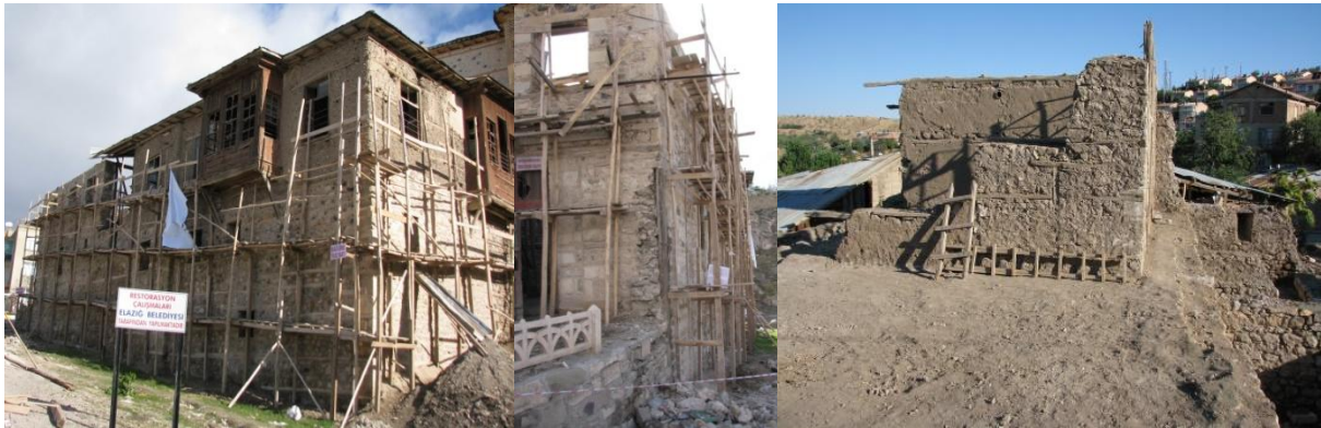
Şek. 56-58: Sağır Müftü Konağı Cephe Onarım Görünüşleri (Ş. Öztürk 2009)
