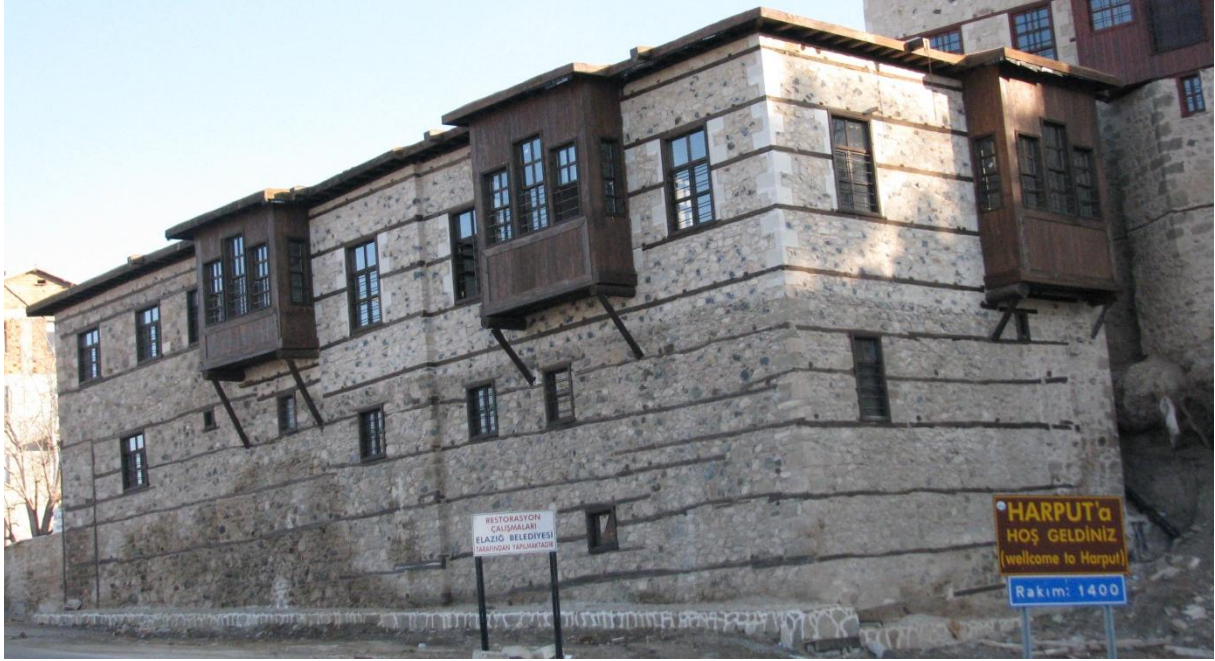
Şek. 96: Sağır Müftü Konağı Güneybatı Genel Görünüşü (Ş. Öztürk 2010)
