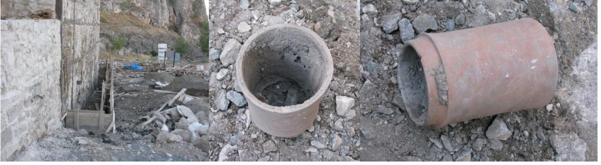
Şek. 86-88: Sağır Müftü Konağı Drenaj Onarım Görünüşleri (Ş. Öztürk 2008)
