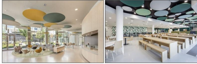
Şekil 31. Akustik tavan paneli örnekleri (Ur17), (Ur18)
