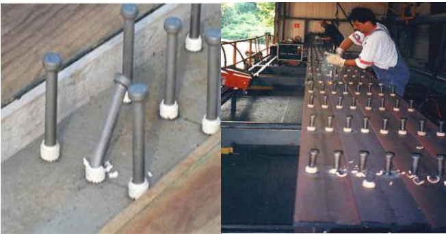
Şekil 4. Derz birleşimleri için bırakılan boşluk ve kaynak sapsamaları
