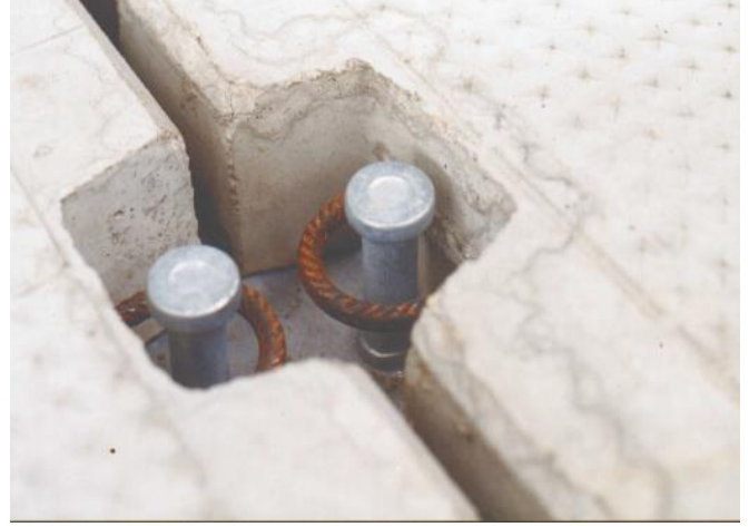
Şekil 5. Saplama kaynak uygulamaları
