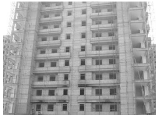
b) Dış cephe mantolama örneği
