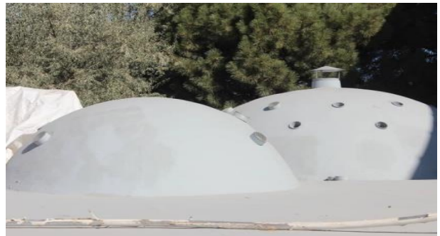
Şekil 14. Cimsit Bey hamamı restorasyon sonrası kubbe görünümü [16].
