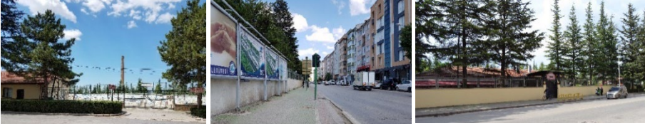
Şekil 10-11-12. Yerleşkenin güney sınırından görünüm. Soldan sağa; Demirspor Tesisleri girişi, Vali Ali Fuat Caddesi ile Basın Şehitleri Caddesinin kesişimin noktasındaki duvar ve panolar, Devrim Arabaları Müzesi girişi (Kişisel Arşiv, 2018).
