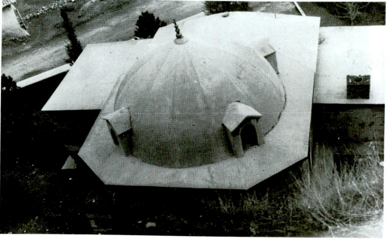
Res. 24 — Akşemseddin Camisi - Örtü (Onarımdan sonra)
