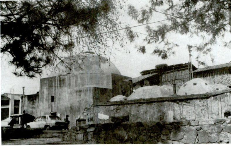
Res. 26 — Paşa Hamamı - Giriş yüzü
