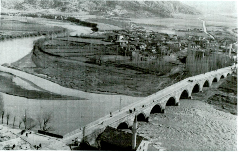
Res. 4 — Osmancık Koyunbaba Köprüsü
