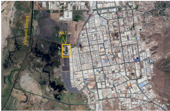
Şekil 3. Kayseri OSB Atıksu Arıtma Tesisi (AAT)'nin görünümü
