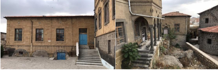
Şekil 5. Erkek Mektebi doğu cephesi ve kuzey cephesi (Yazar, 2020)
