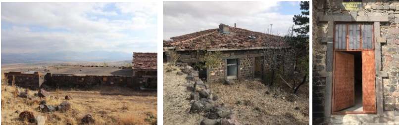
Şekil 11. Balı Rum Okulu iç mekânı, doğu cephesi ve ana giriş kapısı (Yazar, 2020)
