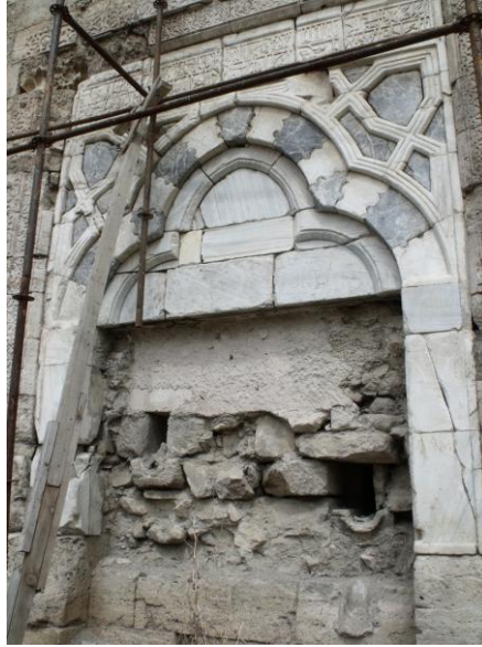
Fot. 6. Gökmedrese çeşmesi.
