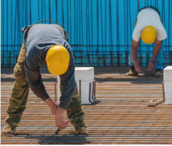
Şekil 8. Donatı demirlerinin kerpeten ve tel yardımıyla bağlanması (URL-5, 2015)
