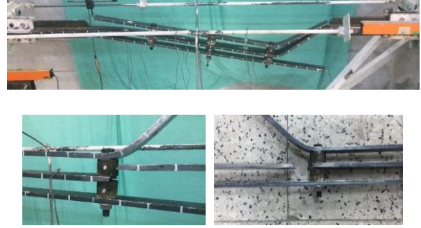
Şekil 21. B-B-1 numunesi test sonrası hasar görünümü
