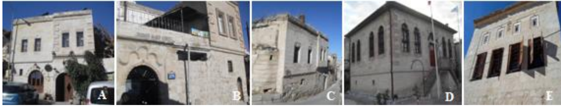
Fotoğraf 17: Konut Cepheleri Pencereler, A.Aydınli Mh. Aydınli Sk., B.Orta Mh. Harim Cami Sk. No: 16, C.Gaferli Mh. Müdür Sk. No: 14, D.Orta Mh. Belediye Cd. (Milli Parklar Müzesi Eski Belediye Binası), E.Orta Mh. Konak Sk. No: 4A (F.Toruk Arşivi)
