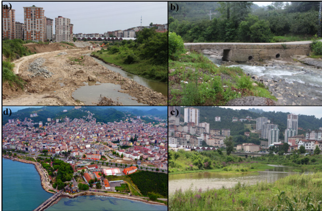
Fotoğraf 1: Fatsa İlçe Merkezi ve Çevresinde a) Derelerin Binalar İle Daraltılması, b) Dere Kesitinin Daraltılması ve Akışı Kolaylaştıracak Yükseklikte Olmaması, c) Elekçi Derenin Fatsa İlçe Merkezinde Kalan Bölümü, d) Fatsa İlçe Merkezinin Dere Yataklarına Doğru Genişlemesi (Fatsa Belediyesi, 2021)
