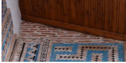
Resim 4: Sahip Ata Türbe giriş koridoru, kuzey duvar
