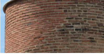
Resim 3: Akşehir Taş Mescit minare
