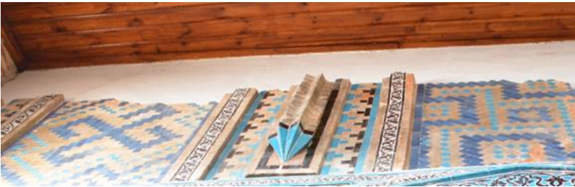
Resim 5: Sahip Ata Türbe giriş koridoru, batı duvar
