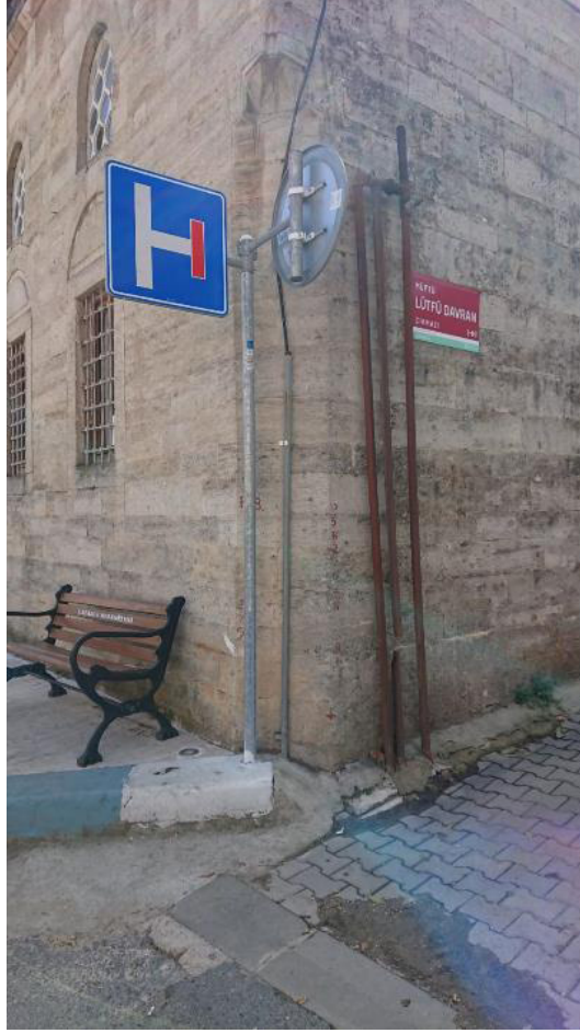
Fot. 33: Çatalca Ferhad Paşa Külliyesi'ndeki Sıbyan Mektebinin Kuzeydoğu Köşesi (Fotoğraf: Ali Gerengi)
