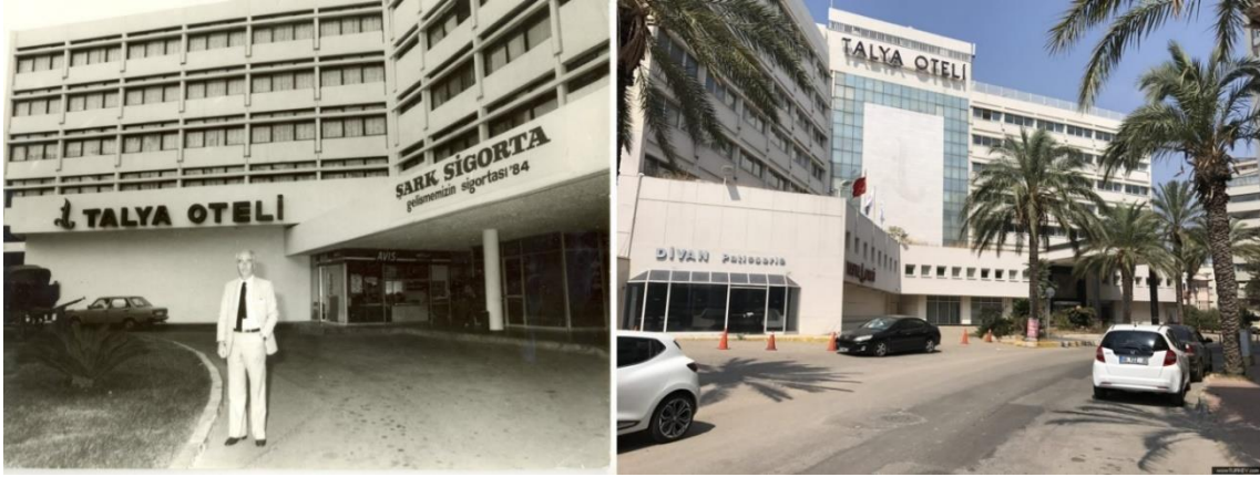
Şekil 6. (sol) Talya Oteli dört yatak katlı iken, (sağ) Talya Oteli altı yatak katlı iken- yıkılmadan önceki son hali (URL-19, 20)
