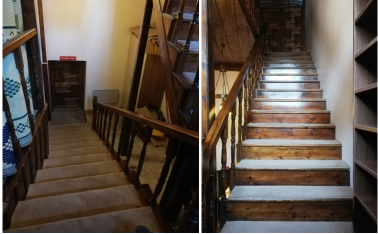
Fot. 27-28: Minare kaidesinin batısındaki mekânda yer alan bodrum katına inen ve kadımlar mahfeline çıkılan merdivenler
