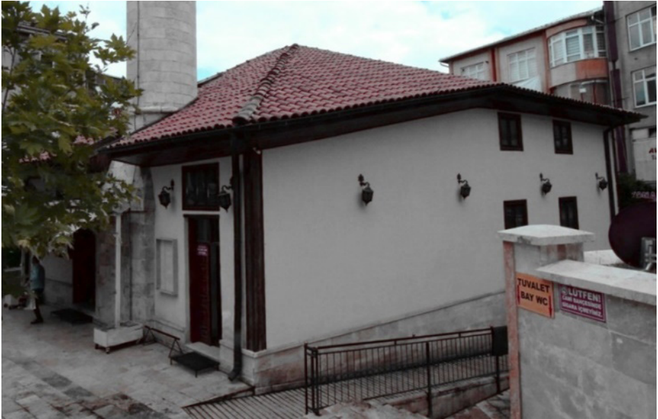
Fot. 23: Batı ve kuzey cephe
