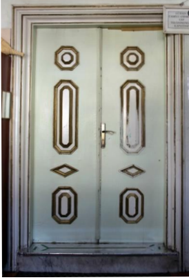
Fot. 12: Harim giriş kapısının dış yüzü restorasyon öncesi
