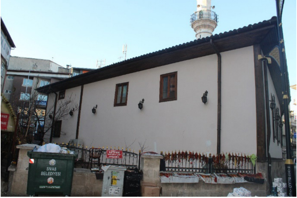
Fot. 22: Güney cephe
