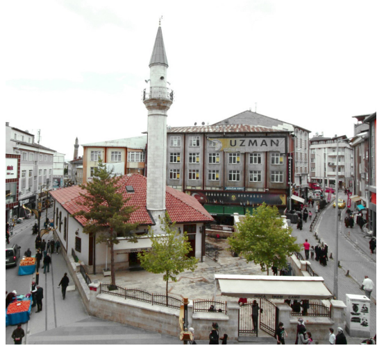
Fot. 20: Caminin kuzeyden görünüşü (restorasyon sonrası)
