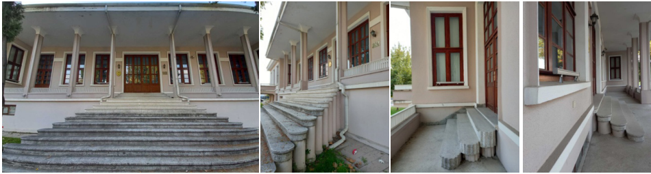
Fot.7: Güneydoğu cephesindeki anıtsal merdiven, revaktaki narin kolon dizisi ve merdivenler, cephe açıklıkları, doğrama detayları, denizliklere sabitlenen aydınlatma elemanları (Yazarlar, 2022).
