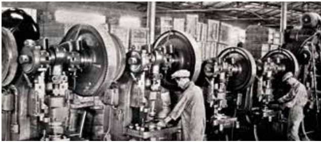
Fotoğraf 11. Batman rafineri tesislerinde asfalt imalat atölyesi (TPAO, 1958, s.13) / Asphalt production atelier in Batman Refinery
