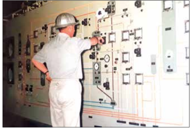
Fotoğraf 12. 1960'lardan sonra modernize edilmiş kumanda odası (TPAO, 1969) / Control room modernized after 1960s
