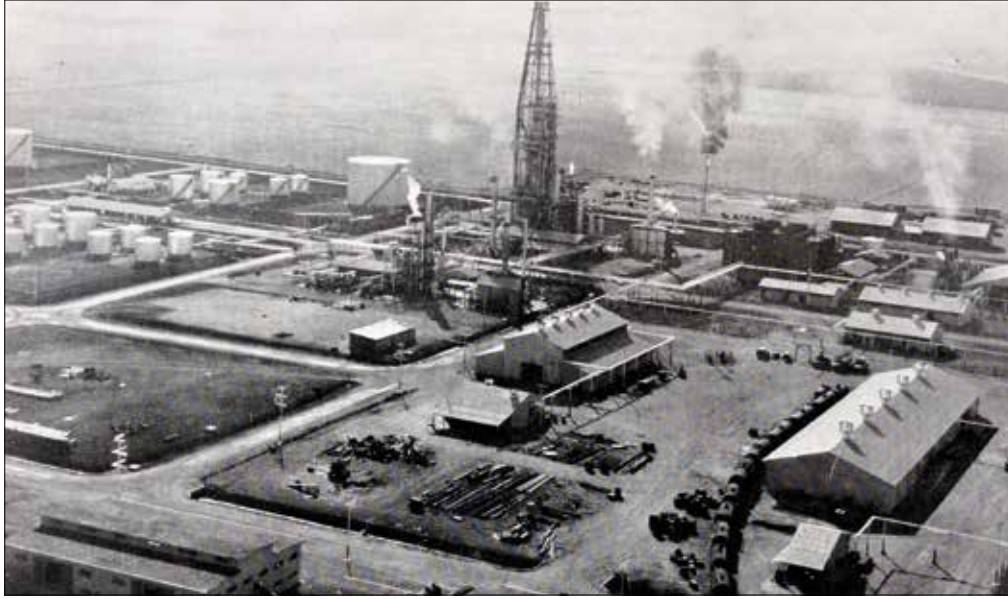
Fotoğraf 10. Batman Rafinerisi ham petrol işleme tesislerinden görünüş (TPAO,1958, s.10) / General view from Batman crude oil refinery
