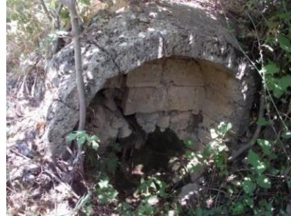
Resim-11. Osmanpaşa Çeşmesi Ön Cephe Görünümü
