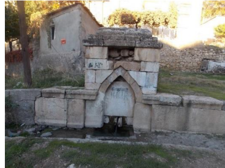
Resim-9. Gümüşpınar Çeşmesi Ön Cephe Görünümü
