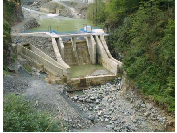
ekil 9. Dere yatağına bırakılan ancak su miktarı yetersiz olan ve balık geçidi aktif kullanılmayan bir bent (Aksungur ve ark. 2011)
