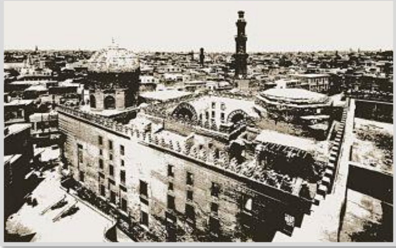
Kalavun Külliyesi'nin Bîmâristan Kısmı
