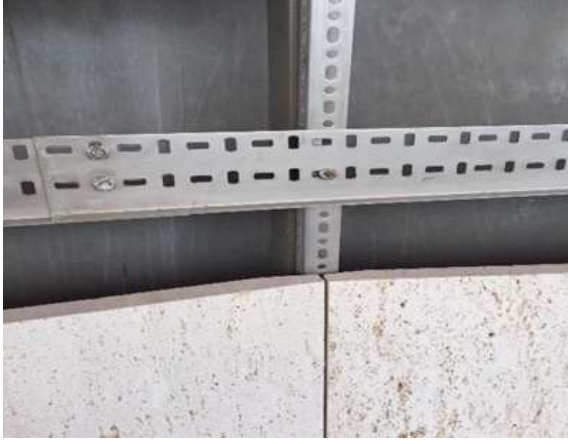
Resim 8. Profilli ankraj sistemi
