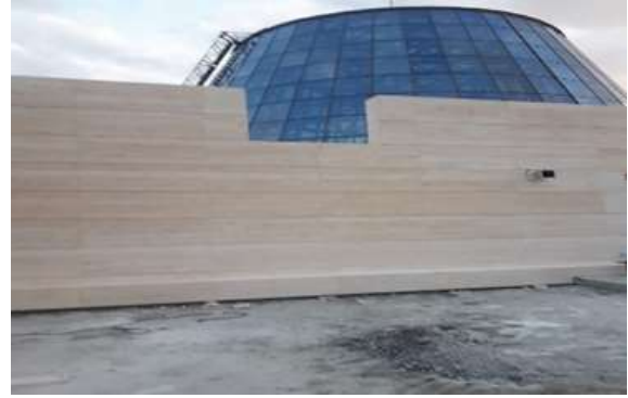
Resim 6. Harçlı dış cephe kaplaması uygulaması
