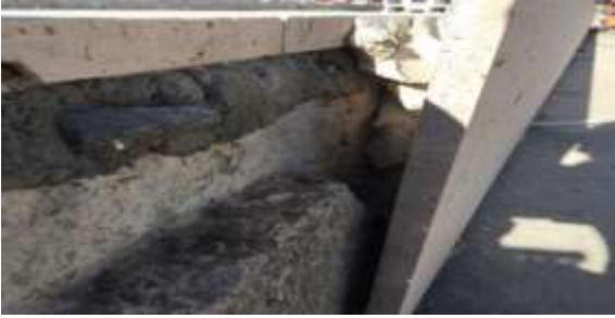
Resim 4. Harçlı dış cephe kaplaması
