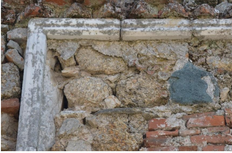
Resim 5: Türbe giriş kapısı üzerindeki çerçeve içinde Palmet kabartması
