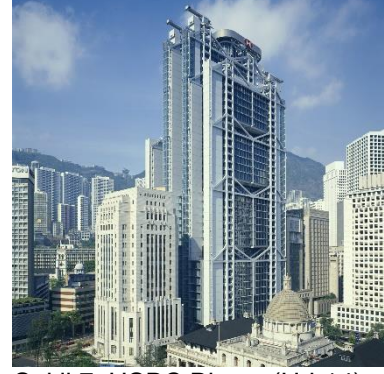
Şekil 7. HSBC Binası (Url-14)
