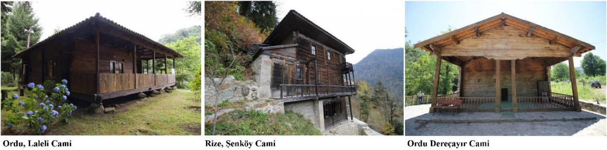
Şekil 4. Ahşap yiğma sistemli camiler kat adedi, çatı ve biçimleniş (DOKAP, 2019).
