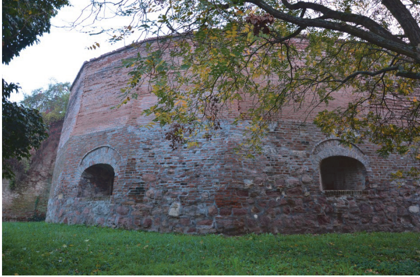
Fotoğraf 7: Sigetvar Kalesi'nde Mustafa Paşa Kulesi'nin dış cephesi
