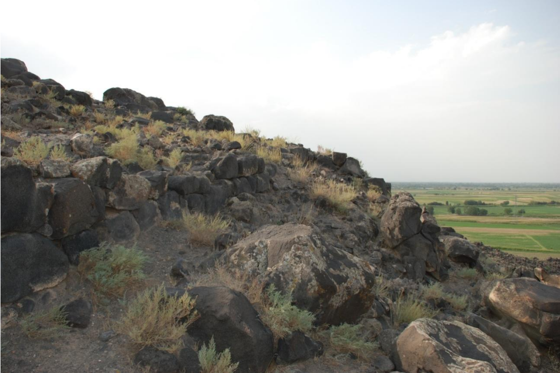
Res. 2: Urartu Dnemi sur duvarları
