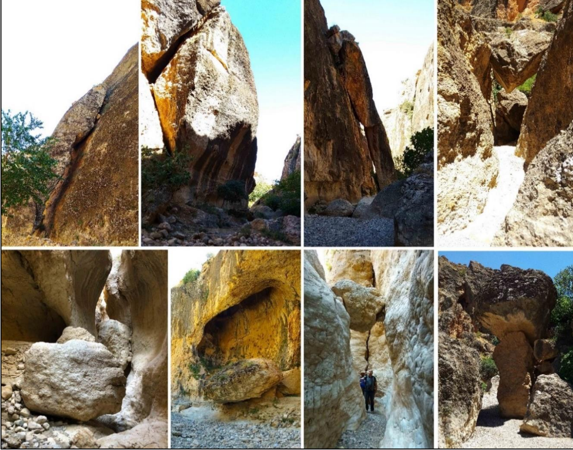
Foto 9. Saklıkapı Kanyonu'nda kaya düşmesi örnekleri, nadir özellikte özel görünüm ortaya çıkarmıştır.
