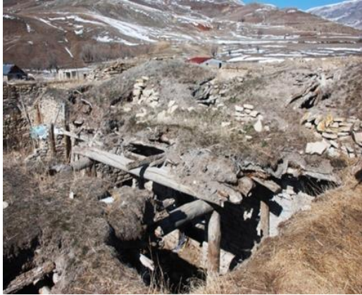
Şekil 11. Yapının güneydoğudan dış görünümü
