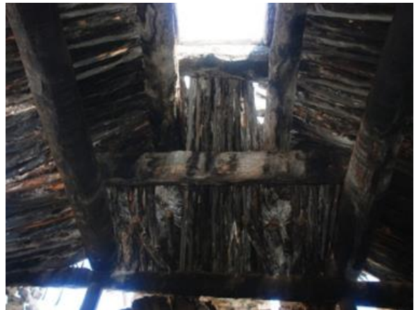
Şekil 6. Yapının mutfak kısmında yer alan tüteklikli örtü sistemi
