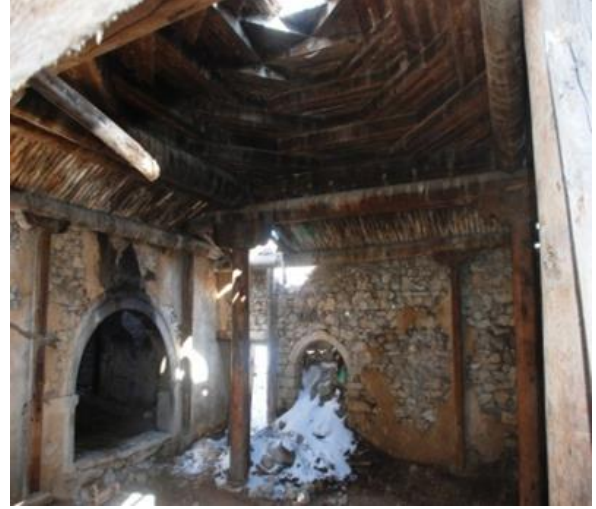
Şekil 4. Yapının ana mekânındaki tüteklikli örtü sistemi
