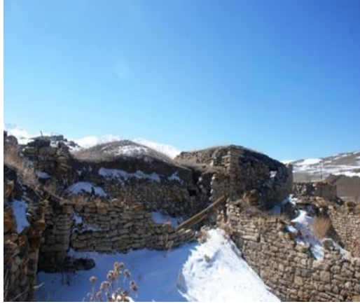
Şekil 10. Yapının kuzeyden dış görünümü
