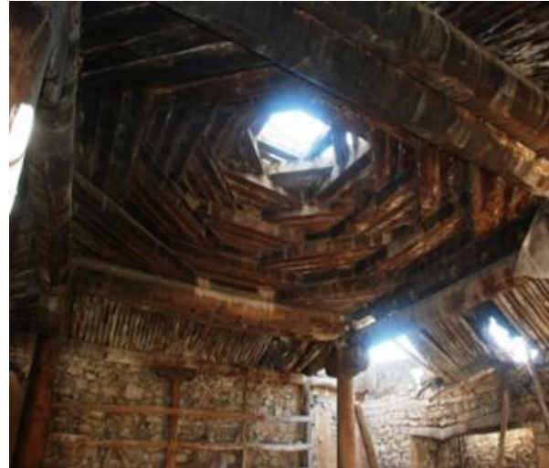
Şekil 5. Yapının ana mekânındaki tüteklikli örtü sistemi
