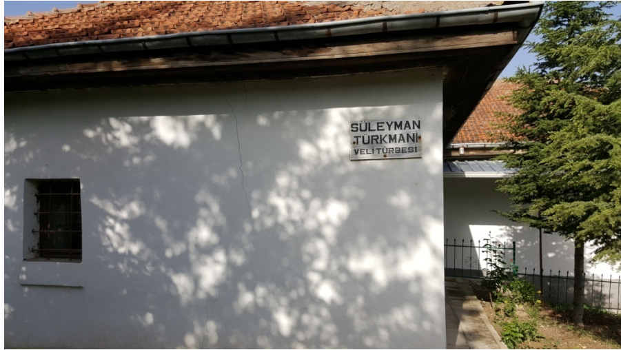
Resim 4: Şeyh Süleyman-ı Türkmanî türbesi...
