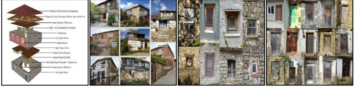
Şekil 12. Taş+tuğla yığma yapım tekniği ile Güzelköy'e ait cephe, pencere ve kapı görselleri kolajı
