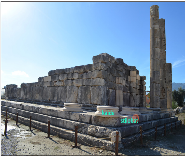
Fotoğraf 7. Yüksek oranda özgün malzemeyle ayağa kaldırılmış kuzeybatı köşedeki üç sütun ve yeni malzemeyle üretilmiş sütun kaidesi ve stilobatlar (28 Ekim 2017). / The three columns in the northwest corner, which were re-erected with a high percentage of original materials, and the column bases and stylobates reproduced with new materials (October 28, 2017).
