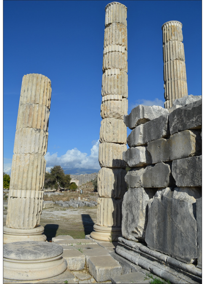
Fotoğraf 9. Sütun tamburlarında kireçtaşından üretilen yeni parçalarla yapılan tamamlamalar (28 Ekim 2017). / Integrations with new pieces made of limestone in column drums (October 28, 2017).
