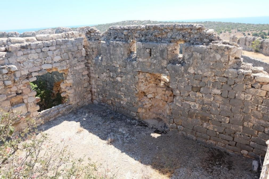
Foto 7: Mescit güney duvarda mihrap ve doğu duvarda pencere açıklığı
