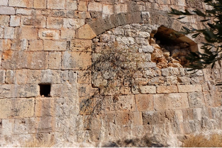
Foto 5: Rampalı bölümün sonraki dönemde kapatılmış hali
