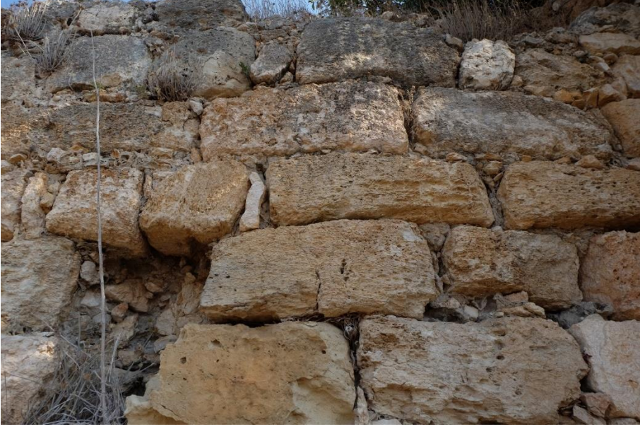
Foto 13: Lamas Kalesi duvar örgü tekniđi
