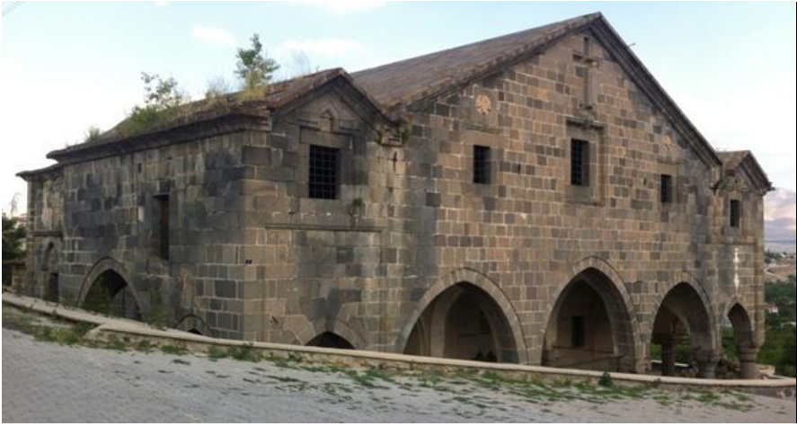
Foto. 3 : Niğde Hamamlı (Kurdunos) Karamanlı Kilisesinin kuzeybatı cephesi
