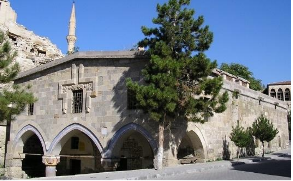
Foto. 37: Nevşehir Mustafapaşa (Sinassos) Konstantin ve Helena Kilisesinin (1729,1850) güneybatı cephesi
