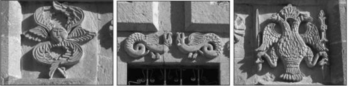
Foto. 38: Nevşehir Mustafapaşa (Sinassos) Konstantin ve Helena Kilisesi (1729,1850) batı cephe detayı (Foto. M.S.Pekak'tan)
