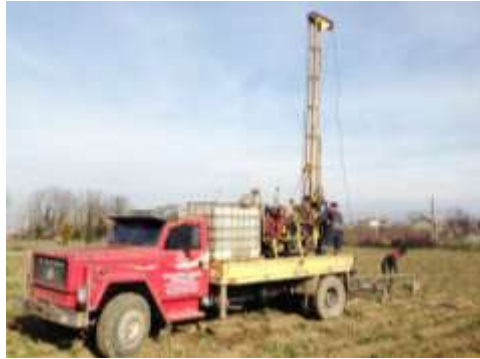
Şekil 3. Arazide SPT deneyine ait sondaj çalışması
