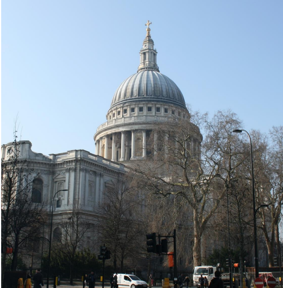
Şekil 11. St. Paul Katedrali Kuzey Cephe
