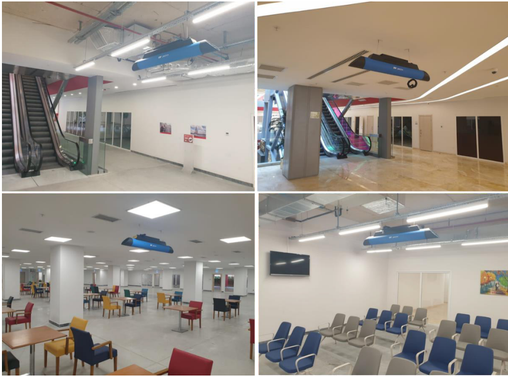
Şekil 11: UV-C Tüp Sistemlerinin Yerleşkenin koridor ve toplantı salonlarına takılması işlemleri.
