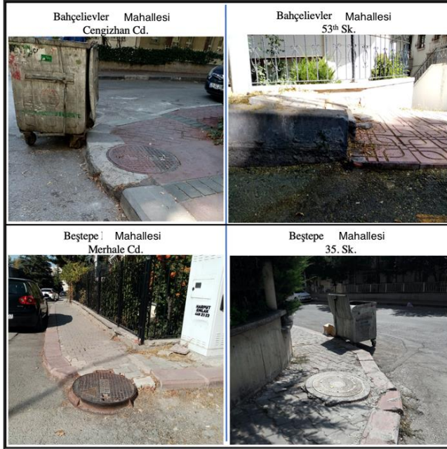
Şekil 15. Rampa Olmadığı Gösteren Kaldırım Bölümlerinden Görüntüler (Yazar, 2021; bu görsel yazar tarafından oluşturulmuştur).
