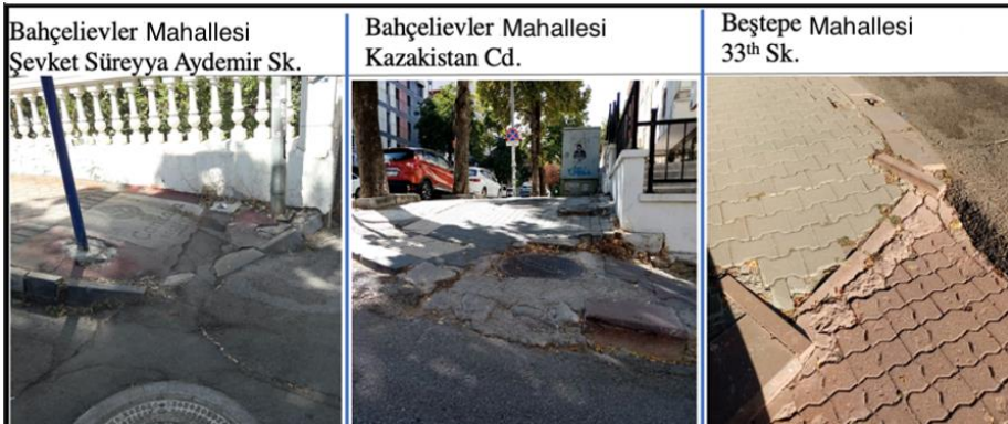
Şekil 19. Çalışma Alanlarında Sorunlu Rampa Yüzeylerinden Örnek Görüntüler (Yazar, 2021; bu görsel yazar tarafından oluşturulmuştur).
