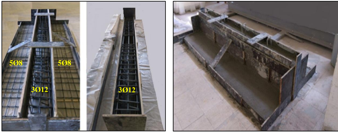
Şekil 6. K1, K2 ve K3 kirişlerinin kalıp ve donatılarının hazırlanması.
