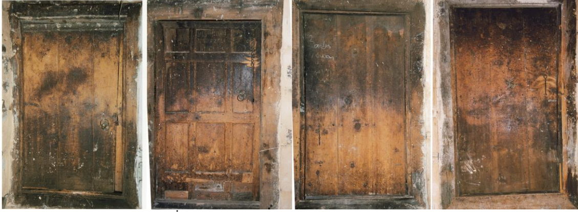
Resim 3. İlvat bölgesi köylerinden zemin kat kapısı örnekleri
