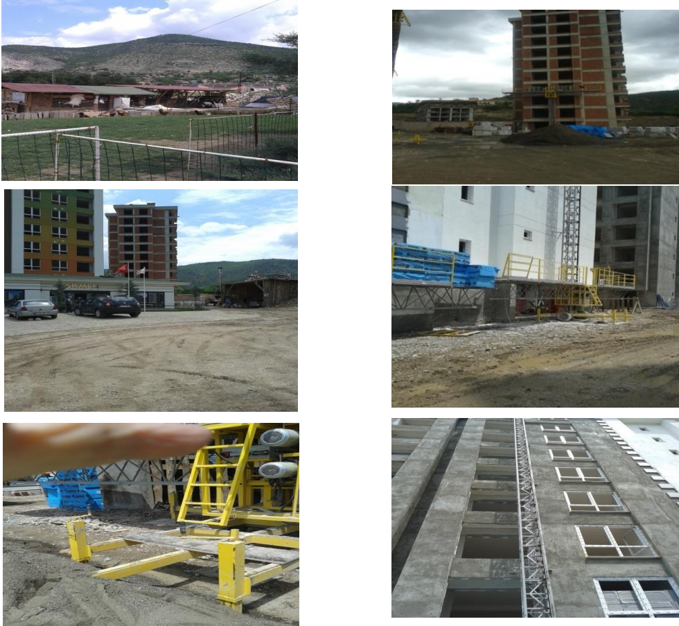
Şekil 9. Hareketli cephe iskele sistem (Figure 9. Mobile scaffolding system)
